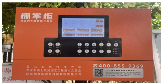
设施园艺智慧控制平台
